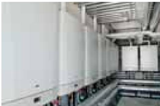
Centralele termice cu condensare din gama Baxi sunt ideale pentru instalarea în cascadă. Datorită sistemelor electronice de înaltă tehnologie (Advanced CPS System), se pot instala până la 12 centrale doar prin conectarea accesoriilor corespunzătoare la sistemul electronic. Domeniul complet de accesorii permite o cascadare a sistemelor ce pot atinge puterea de 780 kW.
